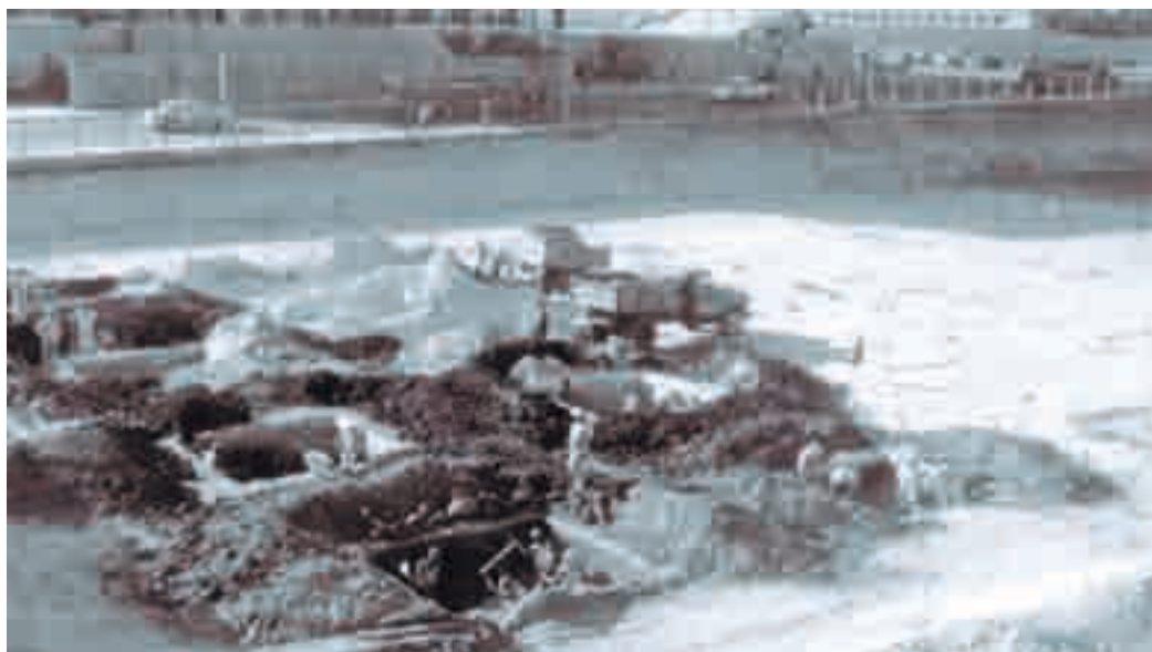
Proceso de excavación para los sótanos de los nuevos edificios del Crédito Hipotecario Nacional y del Banco de Guatemala.
