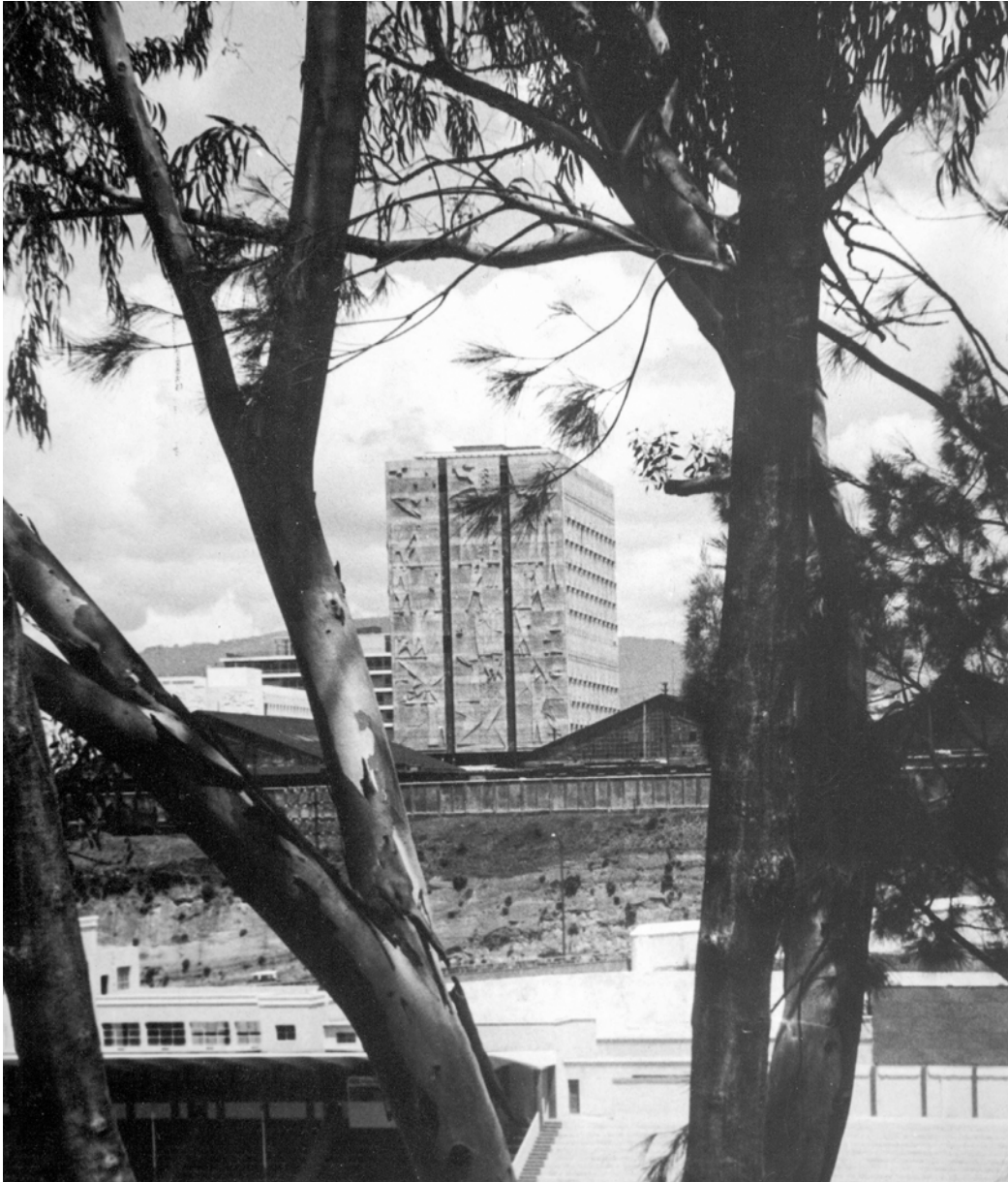
Fotografías del edificio del Banco de Guatemala. Destaca el mural de la fachada oriente, Economía y cultura , de Dagoberto Vásquez Castañeda, visto desde el Estadio Doroteo Guamuch Flores.
